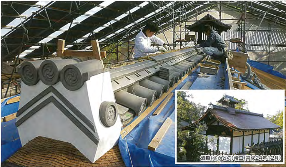
酒殿修理の最終段階。棟瓦の取り付け工事中
