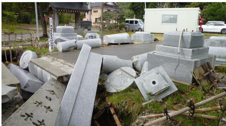
震災により倒壊した石造物。飯田町春日神社表参道
