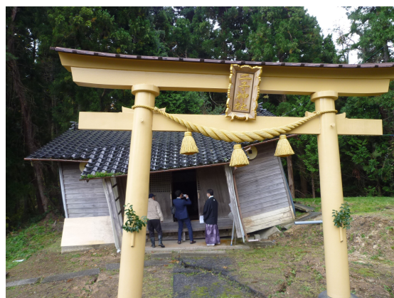
断層の隆起・沈下により倒壊寸前の二子神社
