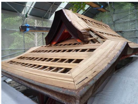
摂社若宮の御本殿御修繕の様子（令和4年）
