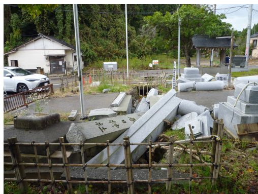
社号標や鳥居が倒れ、そのままとなっている状況
